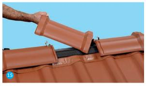
$Am \ Firstende \ Sattelfirstanfänger \ mit \ Spenglerschraube befestigen.$  Den Sattelfirstausgleich Doppelmuffe in die aufgebogenen Firstklammern einpassen, ggf. Firstziegel beischneiden.
