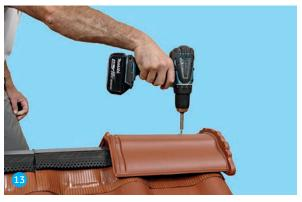
Sattelfirstanfänger mit der Firstklammer und einer Spenglerschraube am Firstanfang und -ende befestigen.
