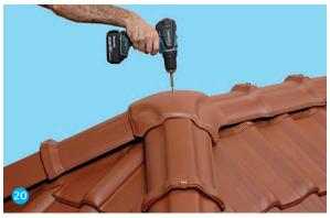
• Walmkappe vorbohren und mit einer Spenglerschraube befestigen.
