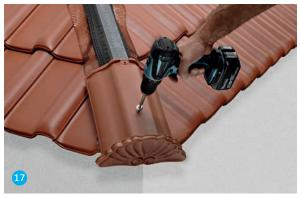
· Sattelfirstanfänger am Grat aufsetzen und mit Firstklammer und einer Spenglerschraube befestigen.
