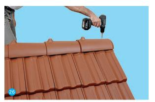
• Firstender aufsetzen und mit einer Spenglerschraube befestigen.
